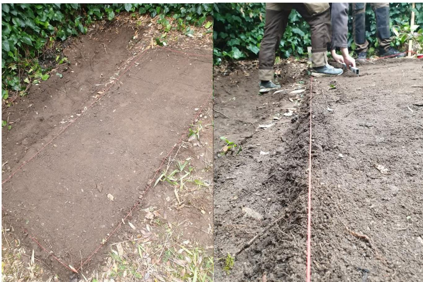
On marque l'emplacement au cordeau. Idéalement légèrement rehaussé à l'endroit où se trouvent les bacs. On compacte le sol aussi pour stabiliser l'emplacement.
